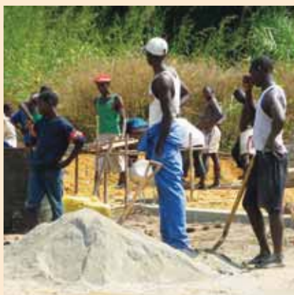
Bei den Bauarbeiten für das Schutzhaus
